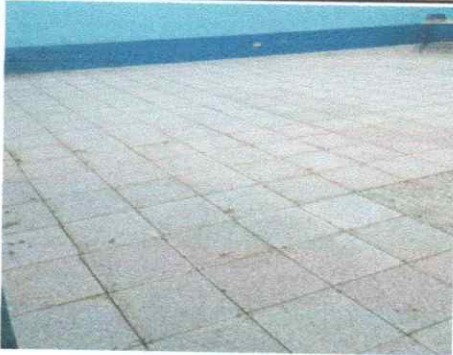
Foto 3: Finalización de piso en aulas de granito
