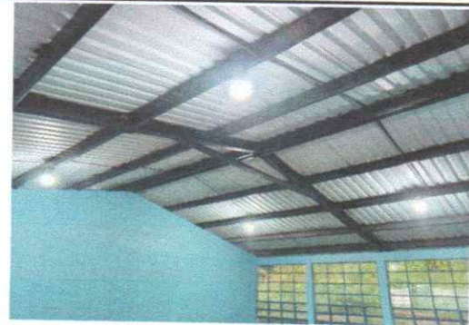
Foto 4: Finalización de sistema eléctrico
