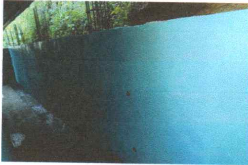
Foto1: Finalización del muro de concreto
