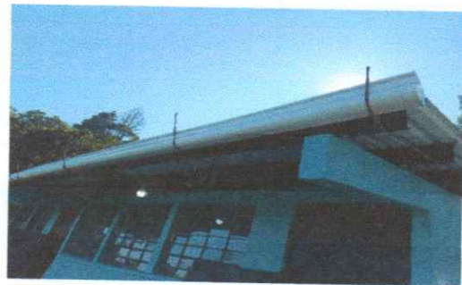
Foto 6: Finalización de canal de pvc pluvial
